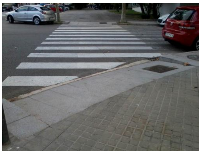
Figura 14. Rampa a la cruïlla del carrer de Pau Gargallo amb l'avinguda del Doctor Gregorio Marañón. Banc d'imatges OSSMA.
