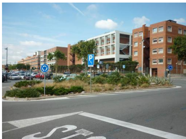
Figura 15. Transformació en rotonda de la cruïlla entre l'avinguda de Joan XXIII i el carrer de Menéndez Pelayo. Banc d'imatges OSSMA.
