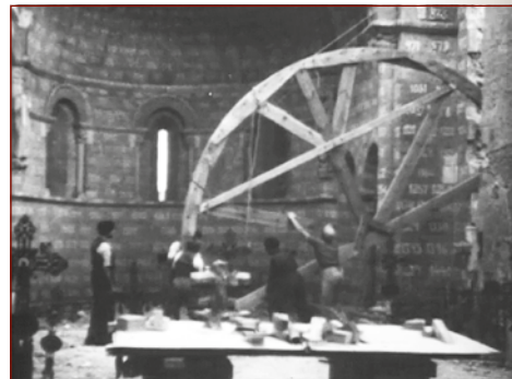
DESMONTANDO EL ÁBSIDE
