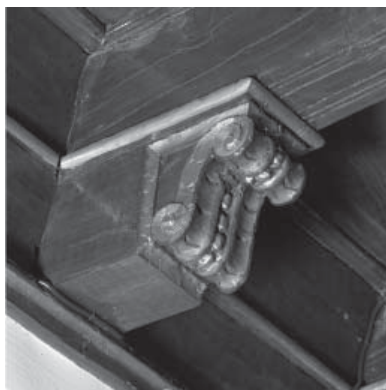
6. Detalle de una ménsula de cartela. Techumbre de la Sala V. (Foto: Álvaro Holgado).
