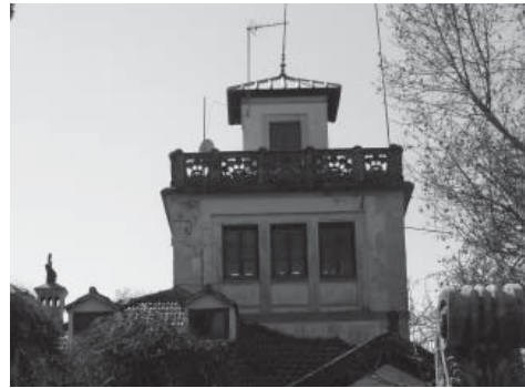
11. Rejería de Avenida de Andalucía s/n.
