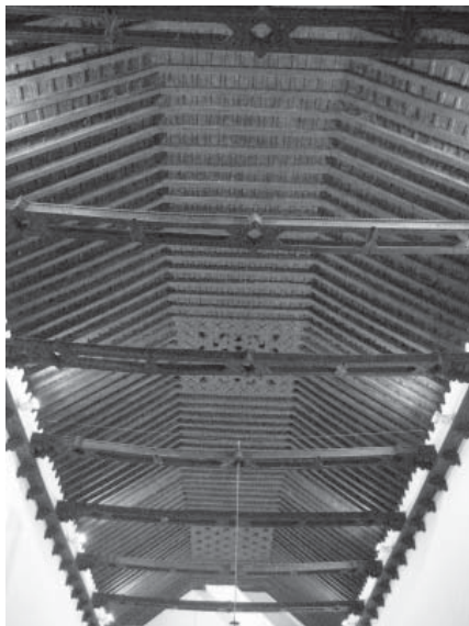
2. Armadura de la nave principal de la parroquia de la Inmaculada Concepción de Almargen, Juan Bautista, 1569.
