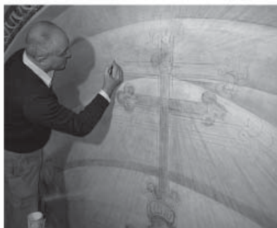
14. La chiesa di San Nicola dei Lorenesi in Roma (XVIII secolo). Il restauro dell'affresco. Le sintesi di progetto finalizzate all'individuazione dello stato normale della Croce (sopra): il rilievo della croce da restaurare guida la definizione delle due fisionomie architettoniche da verificare in relazione alla congruenza di ciascuna con l'intorno che la deve ospitare. L'esecuzione del progetto (sotto) è consistita nella riproduzione della croce di ripristino direttamente sull'intonaco dando corpo alle tracce e reintegrando le lacune. (PUGLIANO A. Cit., Roma 2006).
