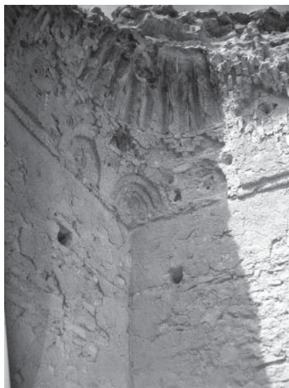
16. Detalle de la imposta de una bóveda en el Palacio de Ujaydir -Iraq- (siglo VIII). (GABRIELI, F., [et al.]. Iraq en los siglos VIII-XIII: el apogeo de la cultura arábigo-musulmana . Madrid, Encuentro, 1998, p. 51).
