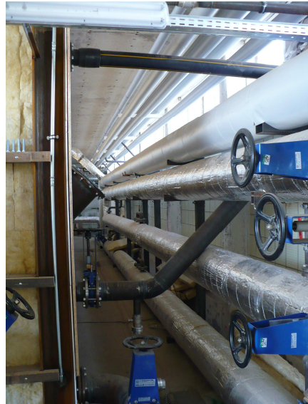
Abb. 72 Rohr - in - Rohr - Wärmetauscher
