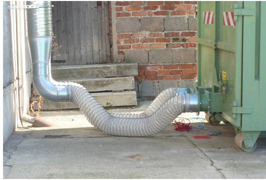
Abb. 89 Flexible Rohrverbindung zum Andocken der Trocknungsluft -Versorgung
