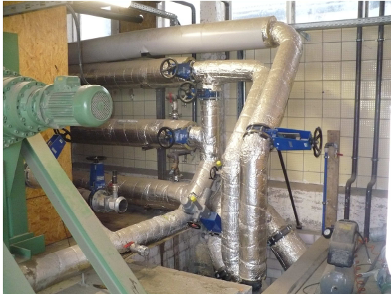
Abb. 71 Rohr- in - Rohr – Wärmetauscher
