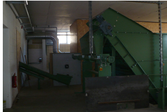
Abb. 74 Ein- und Ausgangsseite des Bandrockners
