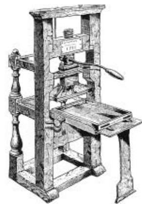
Fig. 30 Siglo XVII. Prensa de brazo. Las prensas de brazo requerían un enorme esfuerzo físico.
