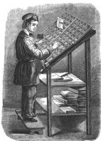
Fig. 5 Postura del compositor. Hasta bien entrado el siglo XVII el cajista componía sentado. En esta figura aparece ya el cajista en su postura habitual, de pie frente al chibalete y la caja (Giulio Pozzoli: Manuale di Tipografia ).
