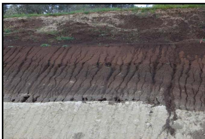
Figura 1 – Fenomeni di erosione incanalata su una scarpata stradale priva di vegetazione
