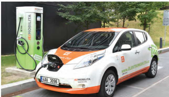
Obr. 7: Rychlodobíjecí stanice (DC) ČEZ v ulici Duhová, Praha 4, na stanici je vidět umístění všech tří standardů (DC – po stranách, vlevo Combo CCS, vpravo CHAdeMO, ze kterého se dobíjí elektromobil, AC zásuvka zepředu stanice) Zdroj: ČEZ, a.s.
