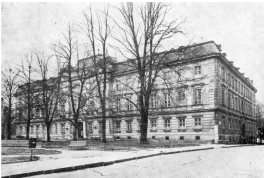
Budova na Antonínské 1 v Brně jakožto první sídlo Ústavu radioelektroniky
