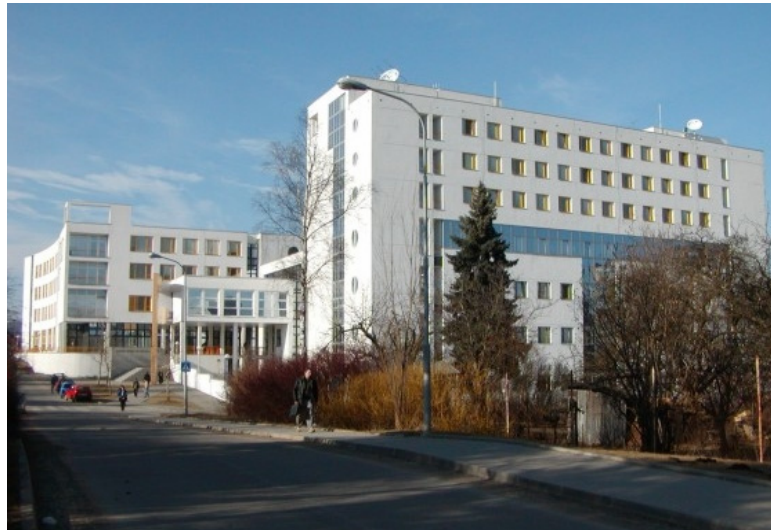
Současné sídlo Ústavu radioelektroniky na Purkyňově 118 v Brně
