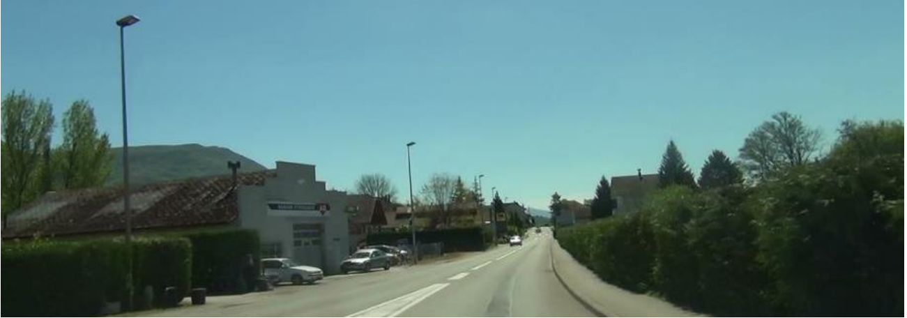
La traversée de Seyssel Haute-Savoie via la RD992 : la fermeture du paysage par des haies mono-spécifiques ou des murs ainsi que la largeur imposante de la route ne donnent pas l'impression d'être en ville (©Nathalie Rouff)
