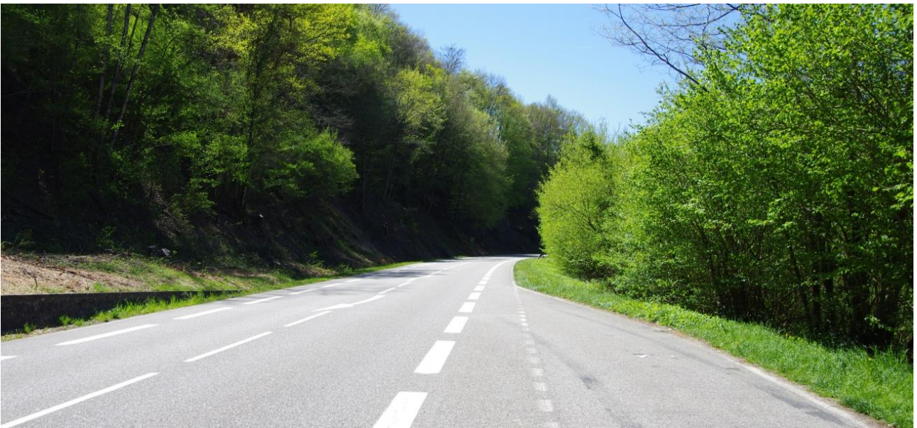
La RD992 est marquée par la présence quasi continue des boisements de part et d'autre de la route, ce qui ne permet pas de percevoir la vallée des Usse, et encore moins le torrent (©Nathalie Rouff)
