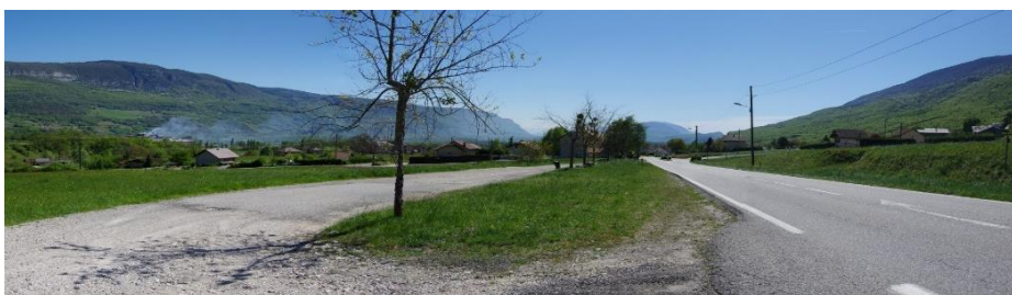
Vue de la RD992, en amont d'Anglefort. Le paysage est plus ouvert et la topographie plus plane en direction du Sud (©Nathalie Rouff)
