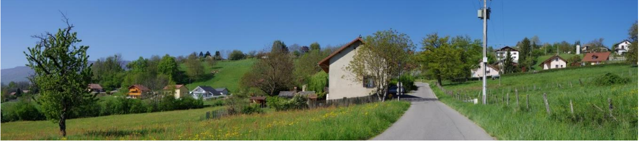
Des constructions le long d'une colline exposée au Sud. Le vieux village n'est plus lisible, l'architecture disparate accentue ce morcellement (Challonges) (©Nathalie Rouff)
