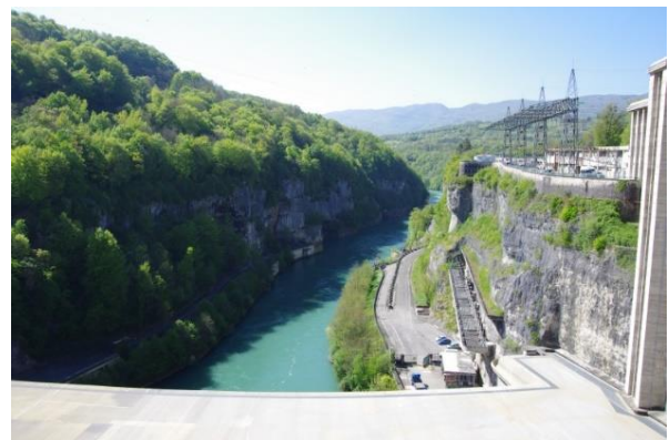
La centrale de Génissiat, un visage industriel offert par le Rhône. Avec la présence des falaises, ce dernier n'est
