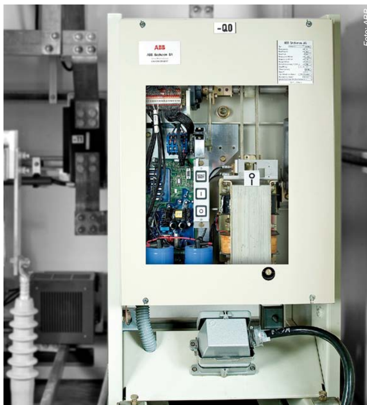
Abbildung 5: 15-kV-Bahnstromleistungsschalter vom Typ GSH 5960.1 mit zwei Kondensatoren.
