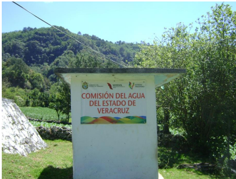
Servicio de Agua Potable regido por CAEV
