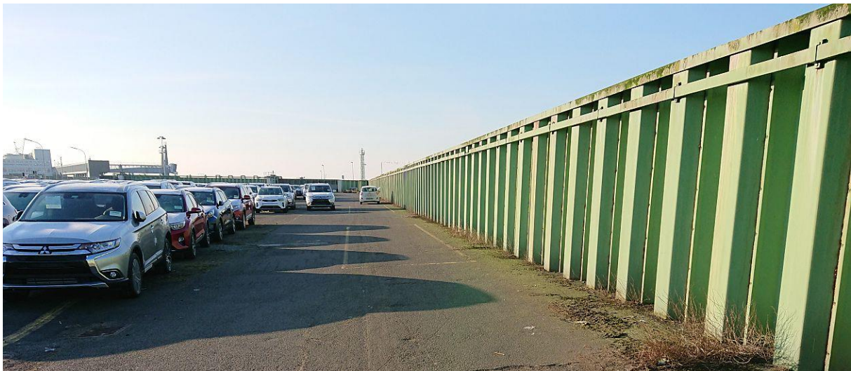
Abbildung 8: Landseitige Ansicht Objektschutz Abstellfläche BLG Automobile
