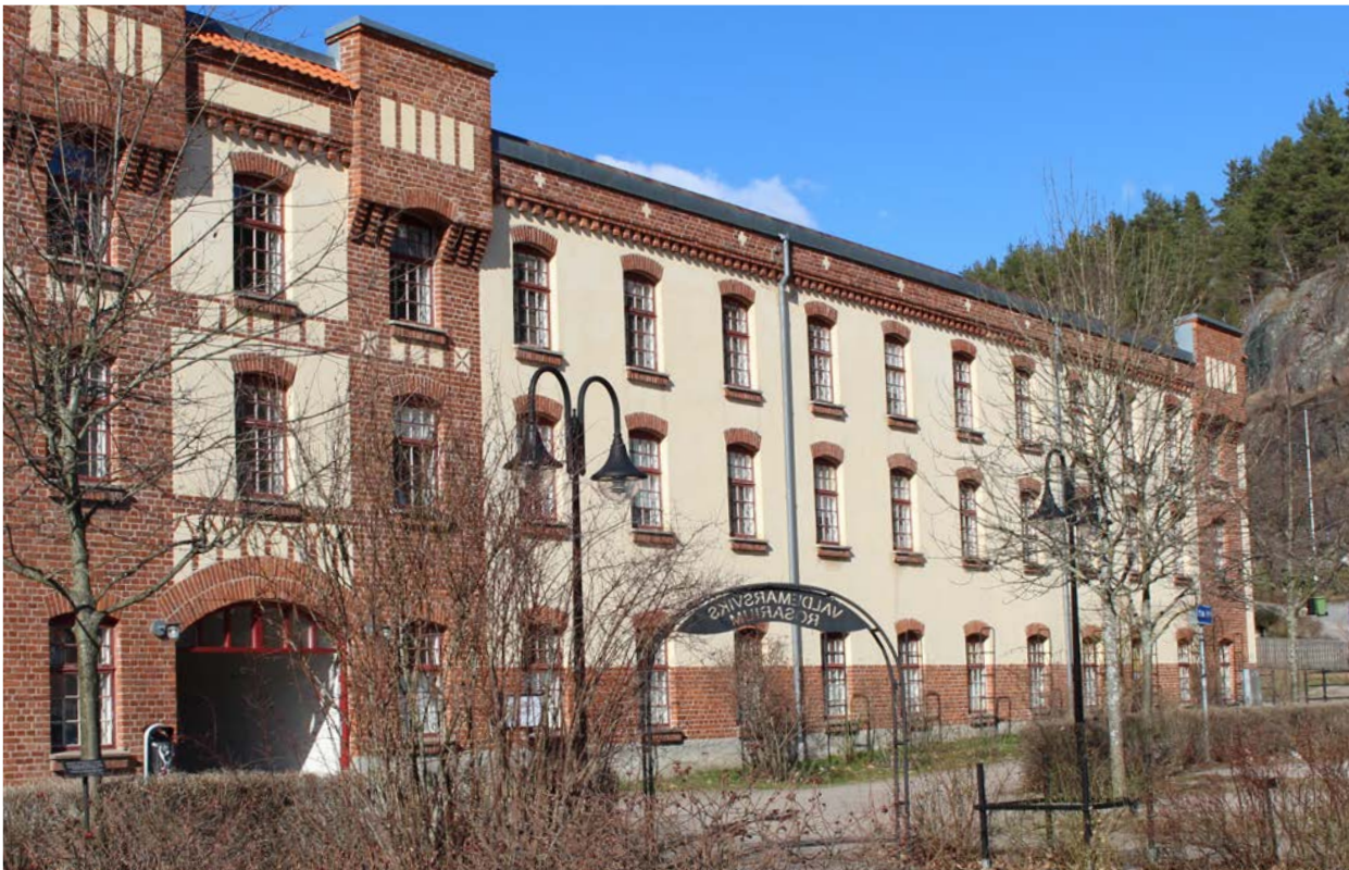
Figur 5:19. Lundbergs läderfabriksbyggnader, här Sjöhuset i Valdemarsvik berättar om ortens industriepok och är en värdefull kulturmiljö.
