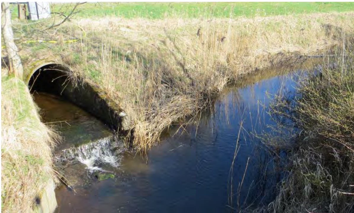
Figur 10. Alebäckens kulverterade mynning i Källeredsbäcken.
