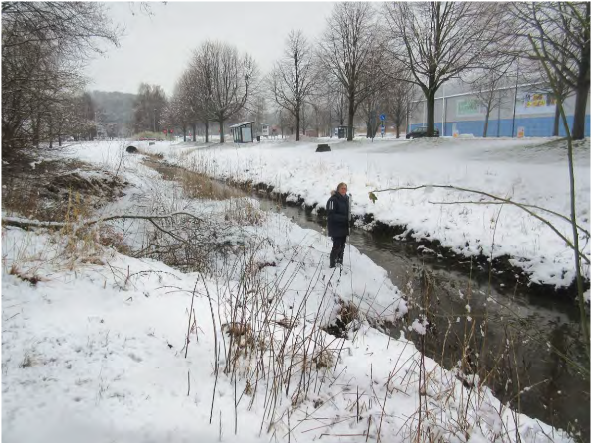
Figur 6. Till vänster i bilden syns ett skredärr, som orsakats av kantererosion. (vattendragssträcka nr 15).
