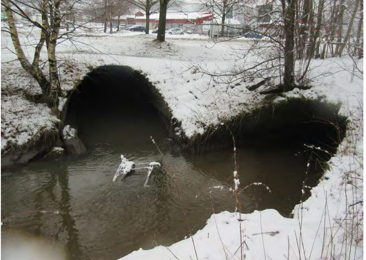
Figur 12. Hagabäckens och Kålleredsbäckens sammanflöde – båda kulverterade
