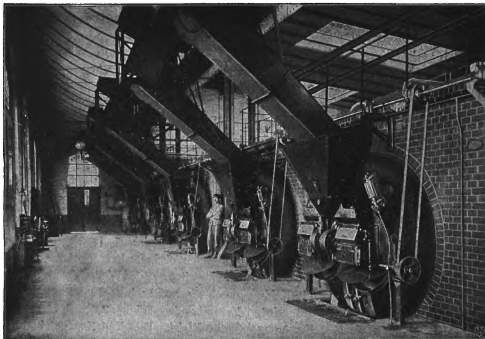
Fig. 223. Kesselhausanlage von Topf & Söhne, Erfurt.
