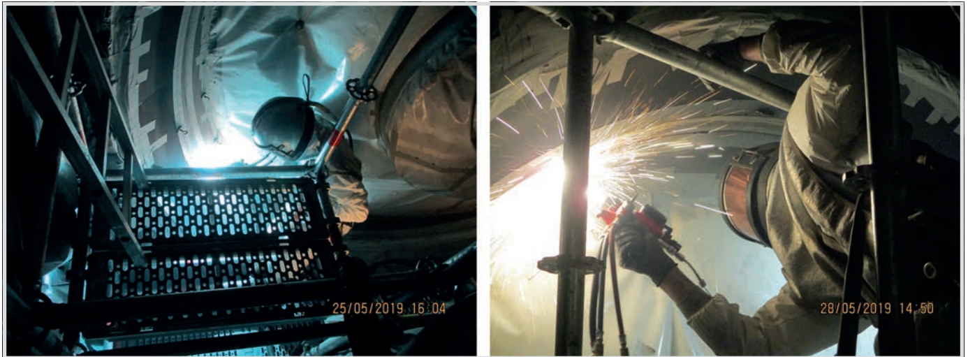
Bild 1a und 1b. Thermisches Spritzen, Ausführung vor Ort.
