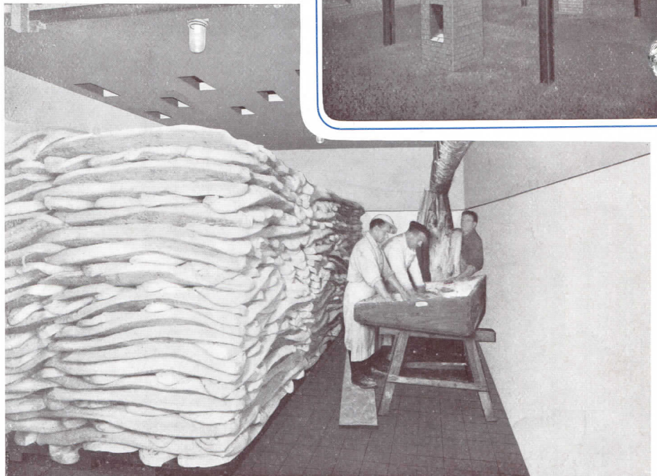
Speckkühlraum in einer jugoslawischen Fleischkonservenfabrik
