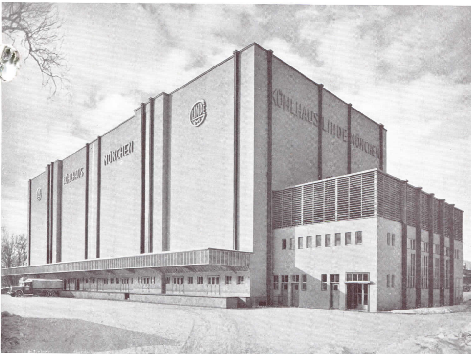
Gesamtbild Kühlhaus LINDE München nach dem Ausbau
