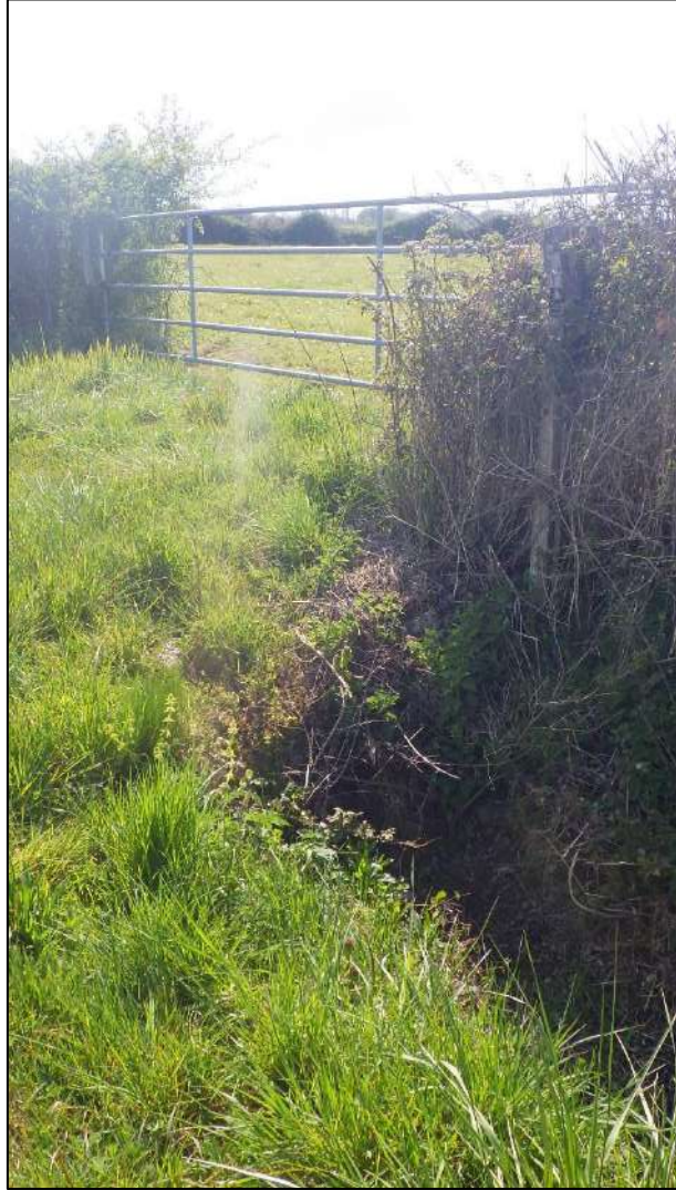
Figure 54 : Photographie de la buse sous l'accès d'un des portails de la parcelle centrale (Source : IDE Environnement, avril 2021)
