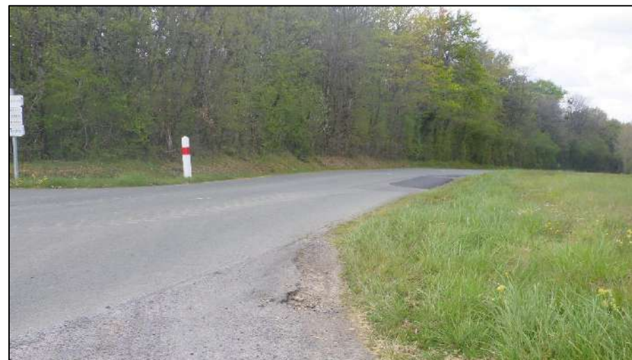
Figure 125 : RD16 située à l'est de l'aire d'étude immédiate
