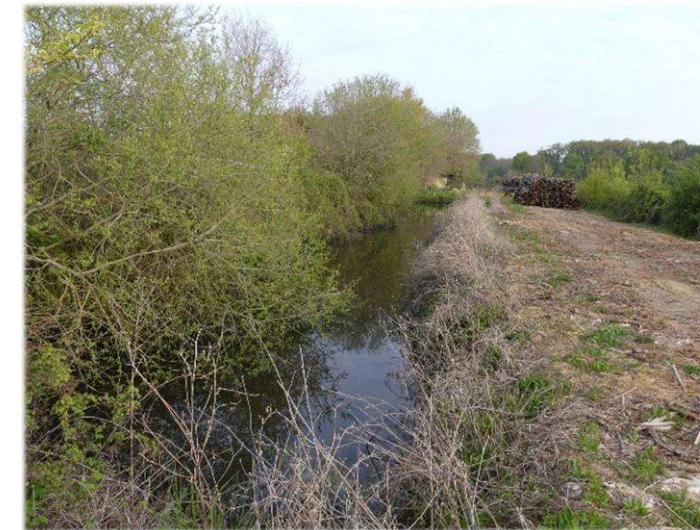
Bassin de rétention
