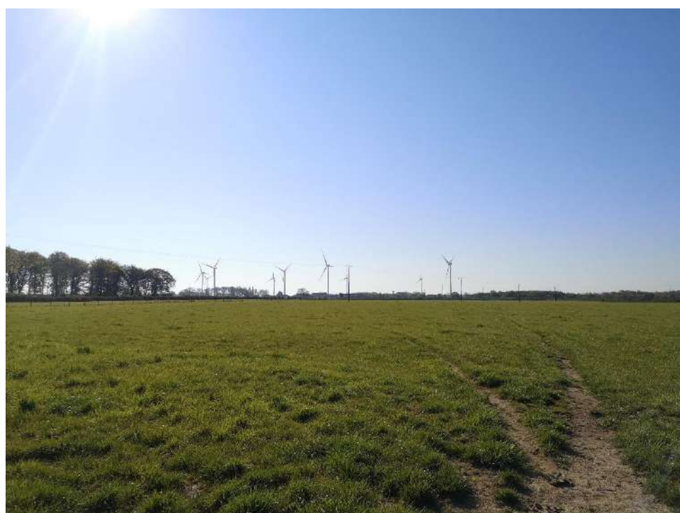
Figure 95 : Vue vers le sud, depuis la partie nord-ouest de l'aire d'étude immédiate Source : IDE Environnement, avril 2021
