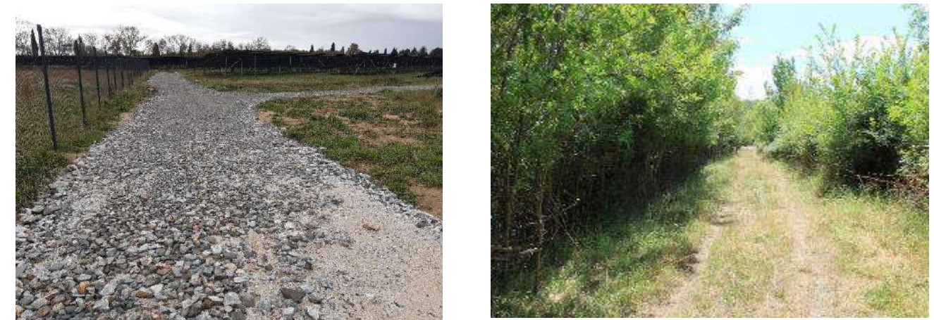
Figure 23 : Exemple de pistes lourde empierrée (à gauche) et légère enherbée (à droite) (Source : IDE Environnement)
