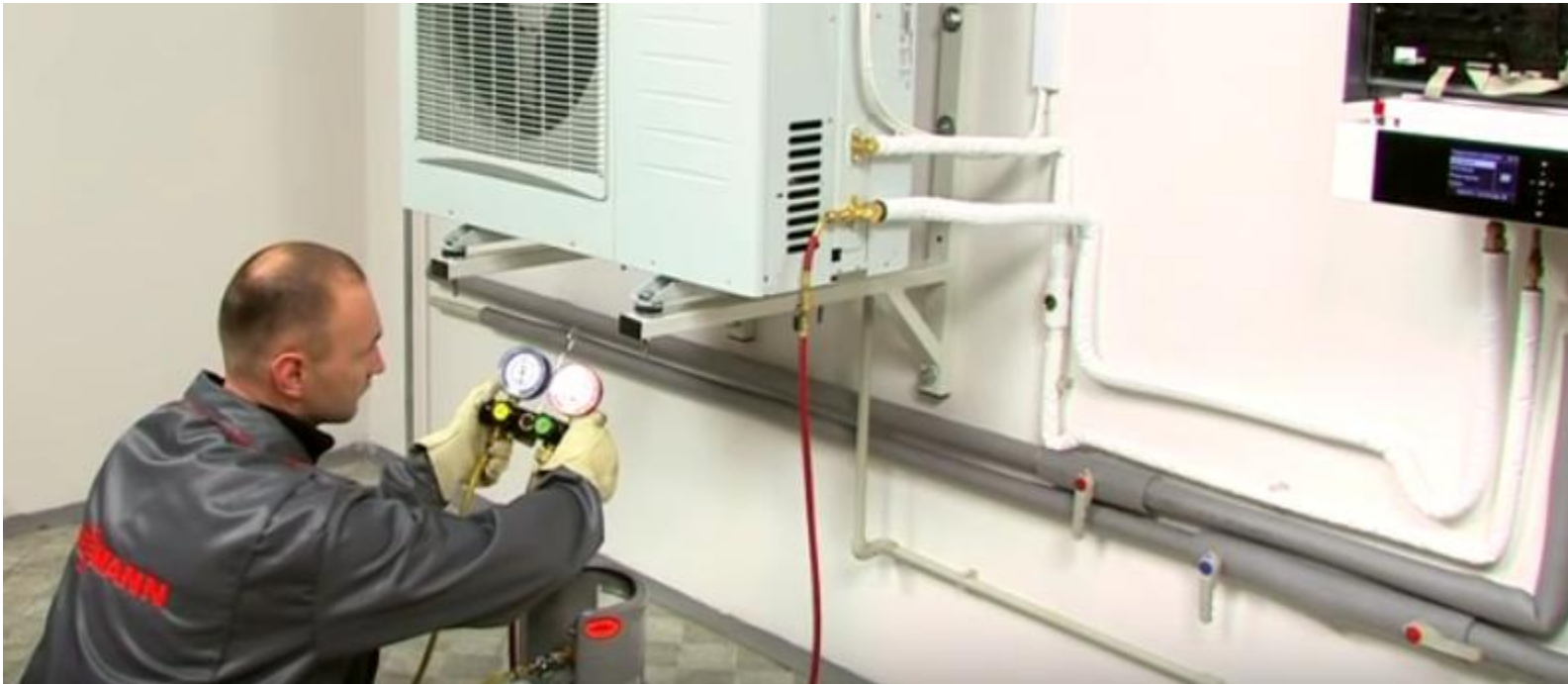
Zdj. Napełnianie układu czynnikiem chłodniczym
