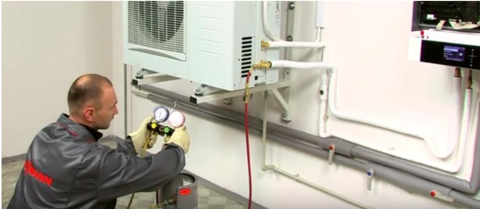
Zdj. Napełnianie układu czynnikiem chłodniczym
