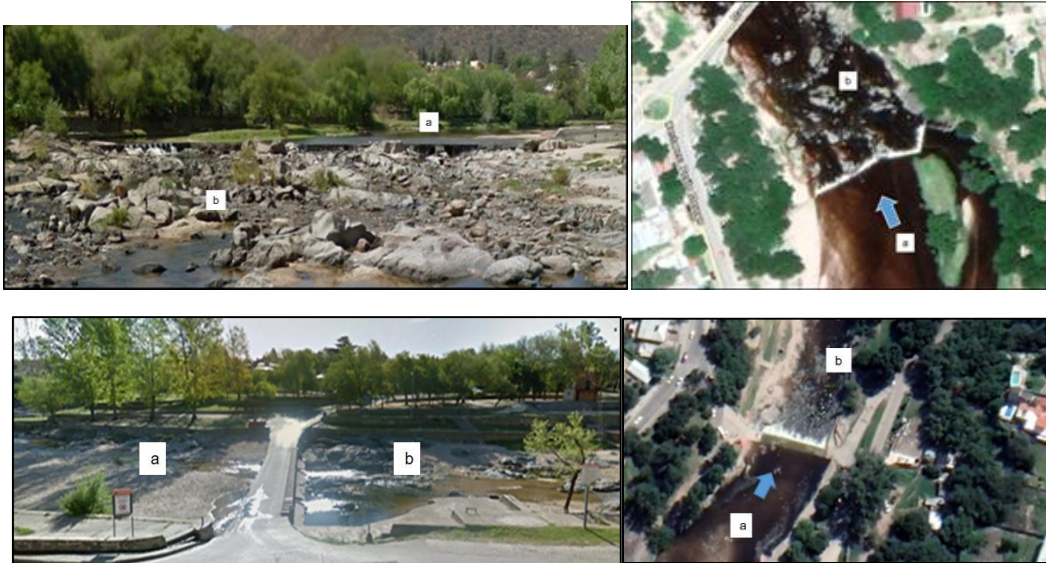
Figura 104. Arriba: Azud Playas de Oro. Efecto por cambio en el perfil de equilibrio del río: (a) colmatación aguas arriba y (b) erosión y arrastre aguas abajo. Arriba: Azud Playas de Oro Abajo: Vado puente El Prado. Fuente: propia.Imagen Quickbird Google earth 2019
