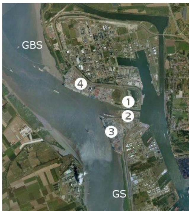
Figuur 2-25: Luchtfoto van het gebied tussen Groot Buitenschoor (GBS) en Galgenschoor (GS). Zandvlietsluis (1), Berendrechtsluis (2), Europa containerterminal (3) en Noordzeeterminal (4) (Scheldeschorren, 2012).
