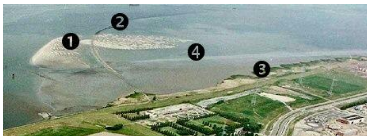
Figuur 2-24: Deze luchtfoto toont de ballastplaat (1), de stroomleidam (2), de smalle strook schor (3) en de uitgestrekte slikplaat en vloodschaar (4) (Scheldeschorren, 2012).
