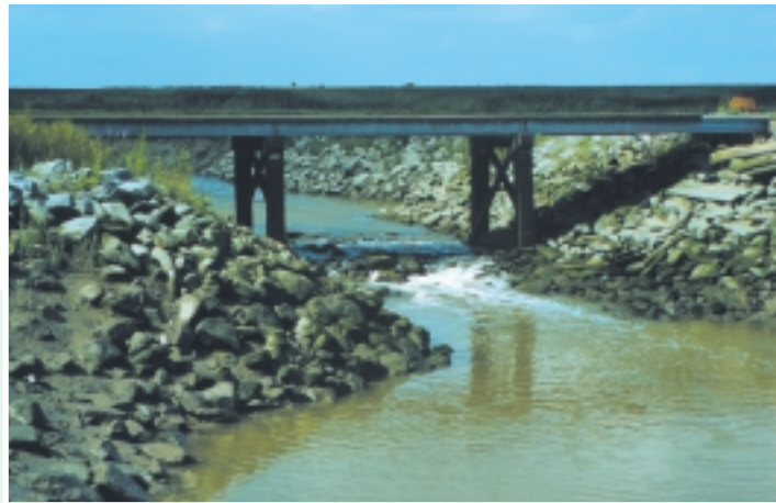
De brug in het Sieperdaschor met de met stortsteen vastgelegde geulbedding
