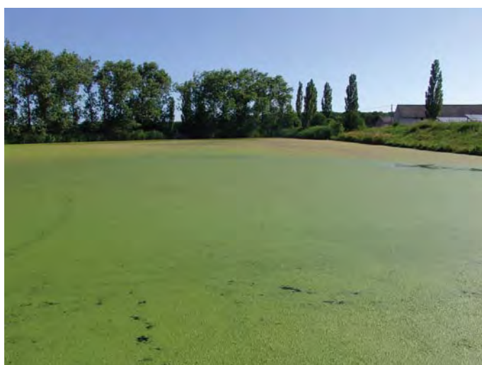
Obr. 2. Stabilizační nádrž, léto 2011 Fig. 2. Stabilization pond, summer 2011
