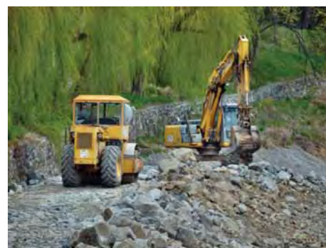
Obr. 20, 21. Postup práce na kamenitým stabilizačním přísypu v horní části návodního svahu hráze na jaře roku 2014
