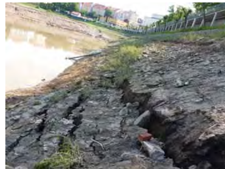
Obr. 16, 17. Podélné trhliny a sesuvy v návodním svahu po náhlém poklesu hladiny v červnu 2013
