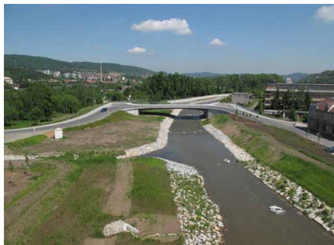
Foto 10. Litavka, Králův Dvůr – pohled po vodě na střední část úpravy s novým mostem
