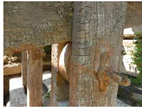
Obr. 10, 11, 12, 13. Unikátní historická dřevěná konstrukce (s opěrným účinkem) hlavního středověkého vodárenského odběru s třemi vrtanými dřevěnými odběrnými potrubími kruhového průřezu. Umístěna je v návodním svahu v levé části hráze; vpravo a vlevo dole důvtipné detaily velmi zachovalé středověké dřevěné vodárenské konstrukce umožňující uzavírání a otevírání vtoků do potrubí; z potrubí se voda rozváděla do městských kašen a do vodárenské věže pomocí trčáků.
