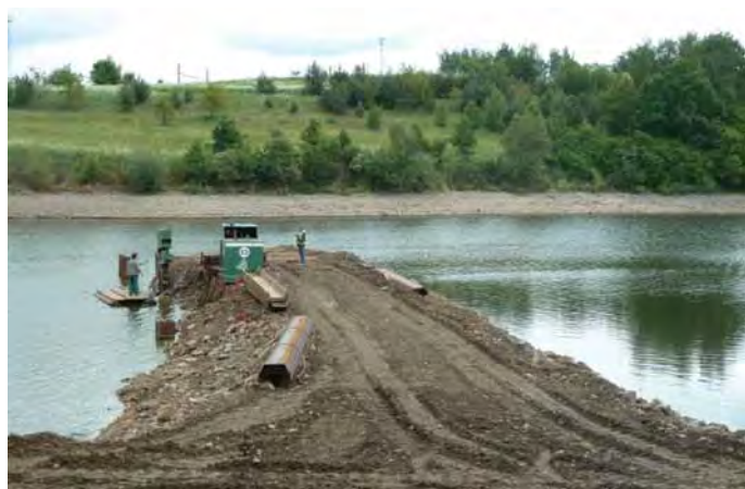
Obr. 4, 5. Postupné sypání dělicí hráčky (vlevo); dokončená dělicí hráčka plně zatížená vodou – srpen 2012 (vpravo)
