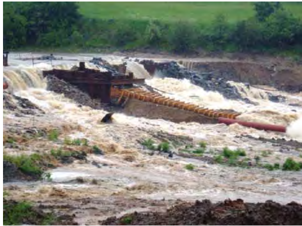
Obr. 6, 7, 8. Druhé a konečné protržení dělicí hráze při povodni v červnu 2013
