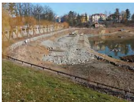
Obr. 20, 21. Postup práce na kamenitým stabilizačním přísypu v horní části návodního svahu hráze na jaře roku 2014
