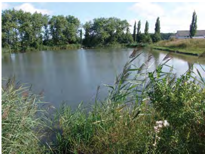
Obr. 15. Stabilizační nádrž, léto 2013 Fig. 15. Stabilization pond, summer 2013
