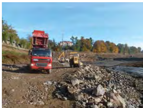
Obr. 18, 19. Postup práce na stabilizaci dolní části návodního svahu hráze koncem roku 2013
