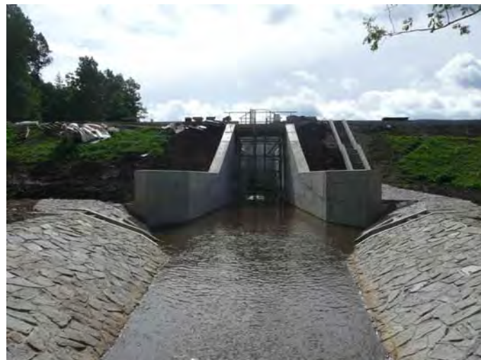
Foto 19. VD Dráteník – pohled proti vodě na dolní část sdruženého objektu umístěného v místě původní spodní výpusti, stav při výstavbě
