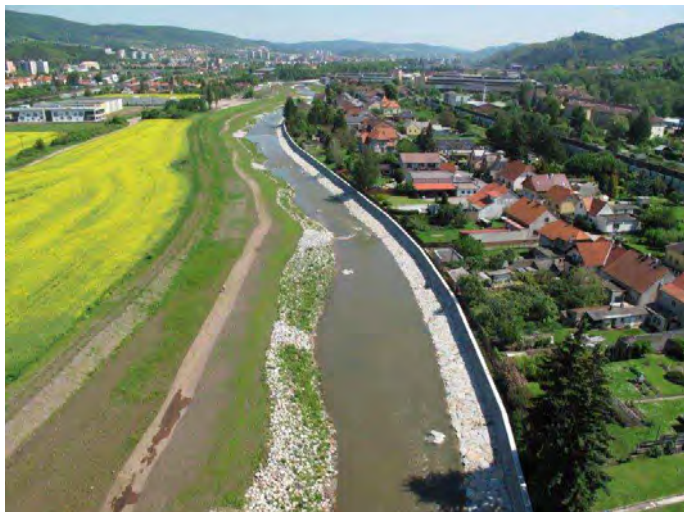
Foto 11. Litavka, Králův Dvůr – pohled po vodě na horní část úpravy
