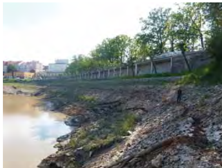
Obr. 16, 17. Podélné trhliny a sesuvy v návodním svahu po náhlém poklesu hladiny v červnu 2013
