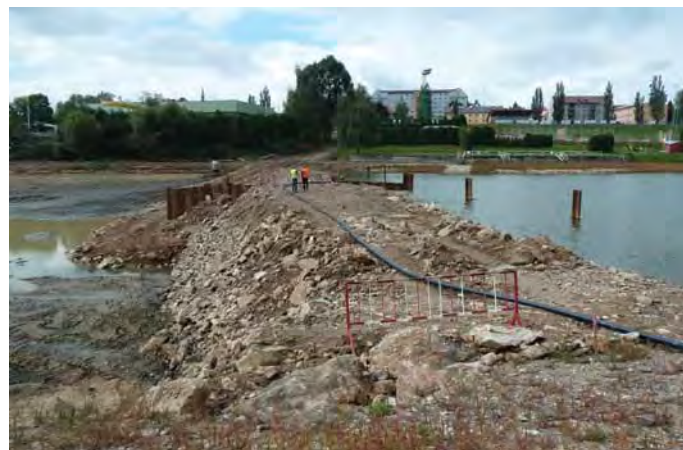
Obr. 4, 5. Postupné sypání dělicí hráčky (vlevo); dokončená dělicí hráčka plně zatížená vodou – srpen 2012 (vpravo)
