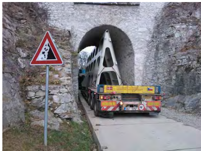
Foto 15. Jez Jelení lávka – jediný příjezd na staveniště, doprava částí jezové konstrukce
