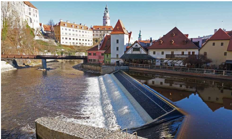
Foto 13. Jez Jelení lávka – pohled na ukončenou stavbu, sektorový uzávěr ve vztyčené poloze
