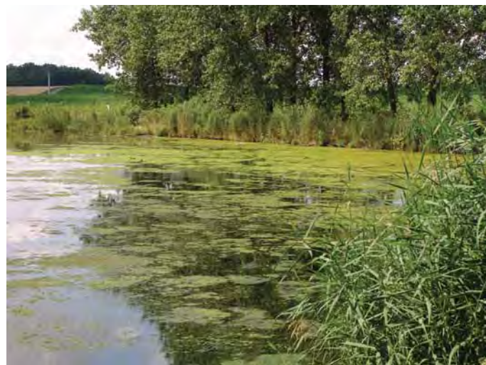
Obr. 16. Stabilizační nádrž, léto 2014 Fig. 16. Stabilization pond, summer 2014
