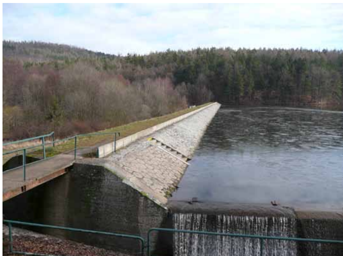
Foto 18. VD Dráteník – pohled z levého břehu na původní stav hráze
