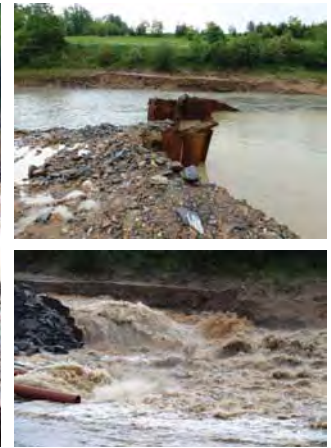
Obr. 6, 7, 8. Druhé a konečné protržení dělicí hráze při povodni v červnu 2013
