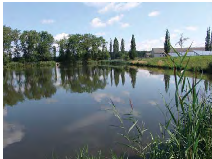
Obr. 14. Stabilizační nádrž, léto 2012 Fig. 14. Stabilization pond, summer 2012
