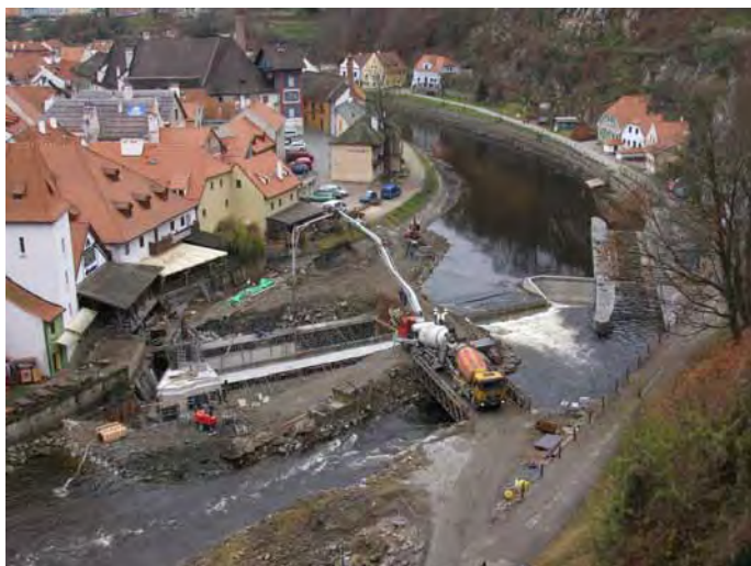
Foto 14. Jez Jelení lávka – stavba probíhala ve stísněných podmínkách města a historické zástavby
