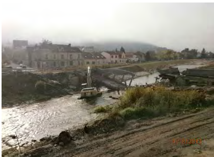
Foto 9. Litavka, Králův Dvůr – bourání silničního mostu s nevyhovující průtočnou kapacitou
