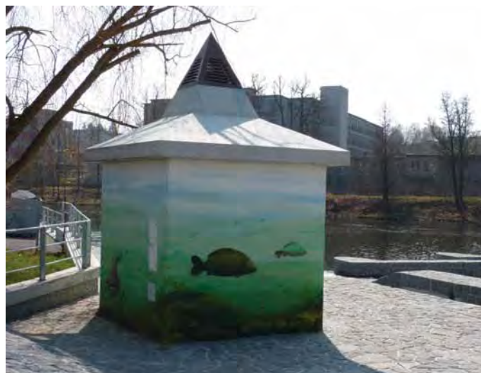
Foto 4. Pohled na ovládací domek vorové propusti ze severozápadu
