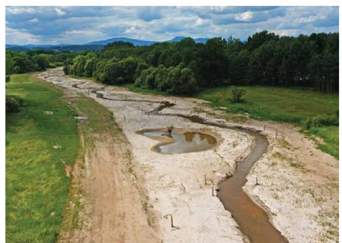
Foto 2. Zájmové území po stavbě (pohled proti proudu)
