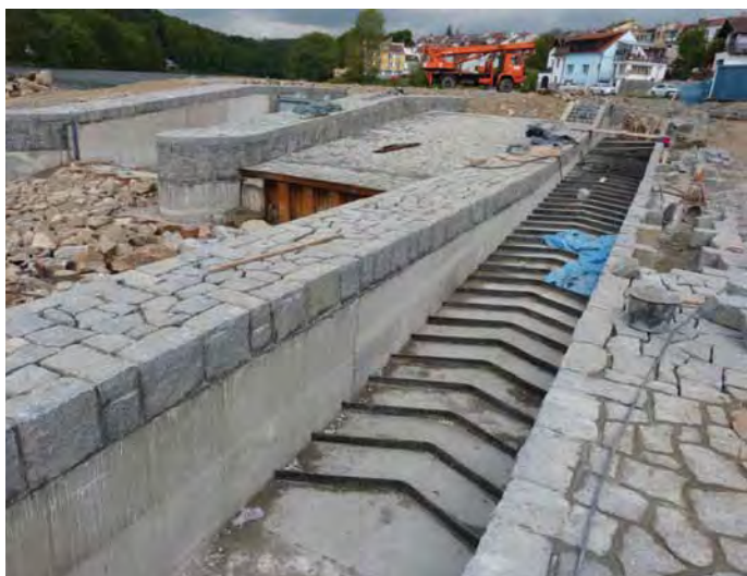
Foto 3. Betonáž dna sportovní propusti
