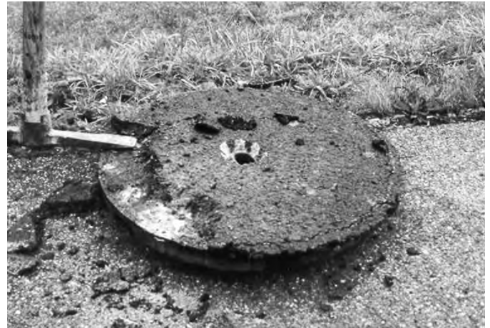
Abdeckung entfernen und reinigen
