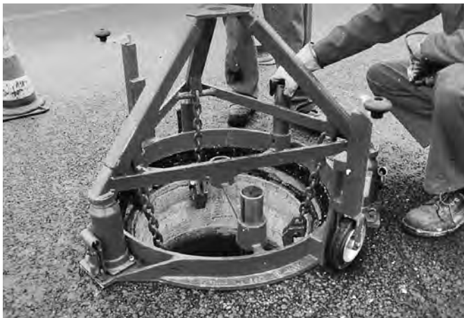
Hochziehen des Rahmens mittels hydraulischen Pressen
