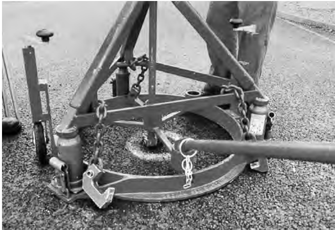
Hochziehen der Abdeckung, Ausstanzen des Belages
