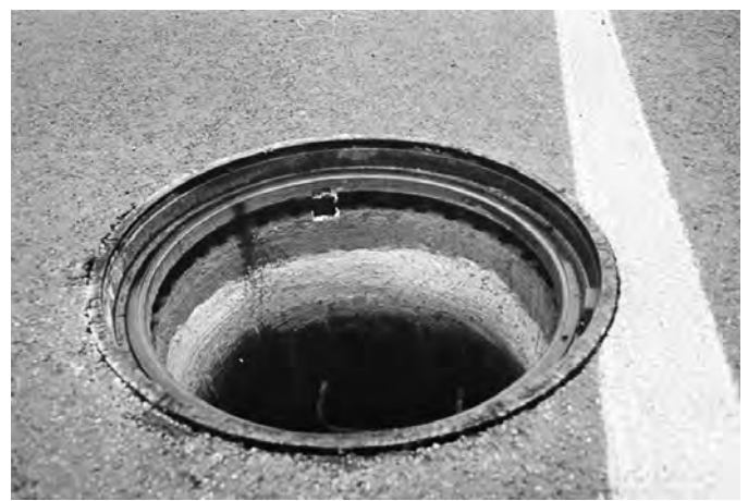
Hochgezogene Rahmen reinigen und befeuchten
