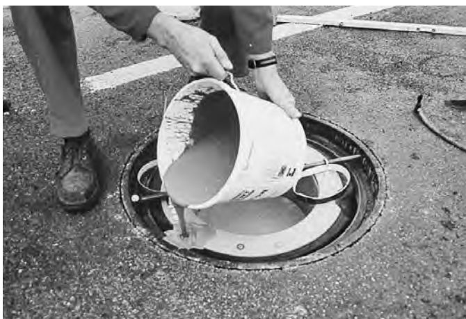
Schlauchschalung Fig. 3280 einsetzen, Addiment Schachtbeton Art. 913142 einfüllen
