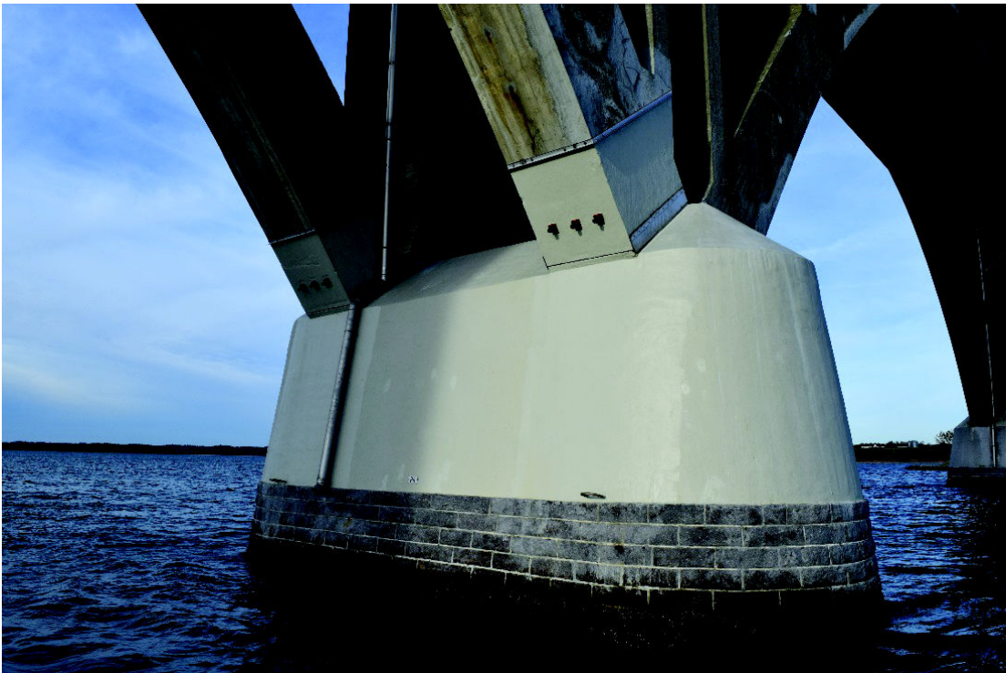
Figur 2-3: Nedre dele af betonbuer efter reparation
