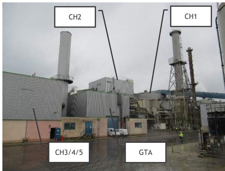
Figure 19. Vue d'ensemble des chaudières et de GTA
