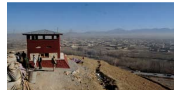
Pozorovací stanoviště postavené PRT
