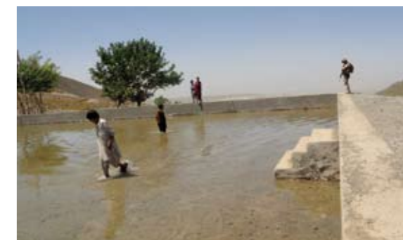
Nová zadržovací nádrž na vodu postavená PRT
