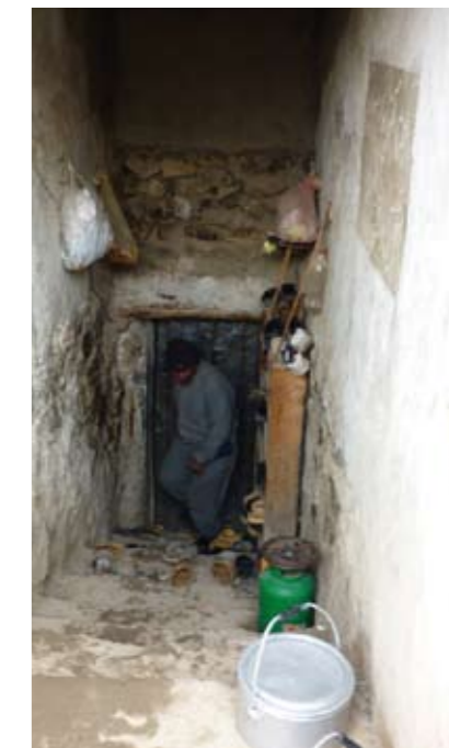
vstup do podzemní cely
