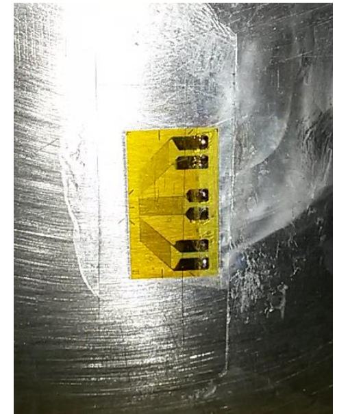
Dehnungsmessstreifen am Sockel des Maschinenträgers
