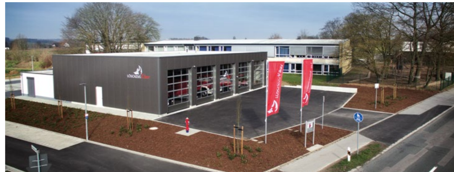
Neubau: Das Feuerwehrhaus des Löschzugs Kilver.
