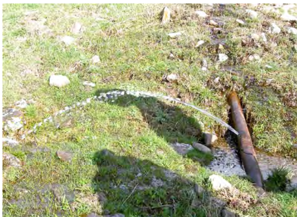
Корозията може да доведе до течове в разпределителната система.
