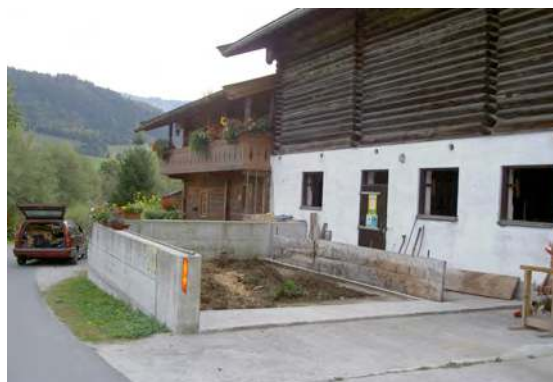
Животинският тор трябва да се съхранява на затворена бетонна платформа
