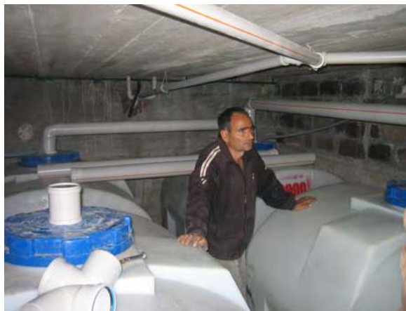
Училищна UDDT(разделна тоалетна): мазе с резервоари за събиране, съхранение и третиране на урина от 350 потребители
