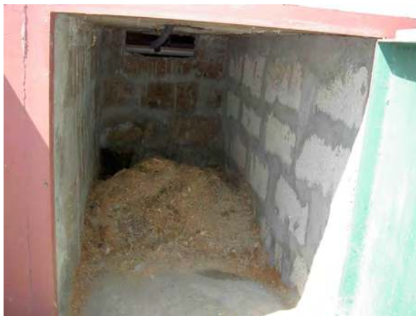
Училищна UDDT (разделна тоалетна): камера за събиране, съхранение и третиране на фекалии
