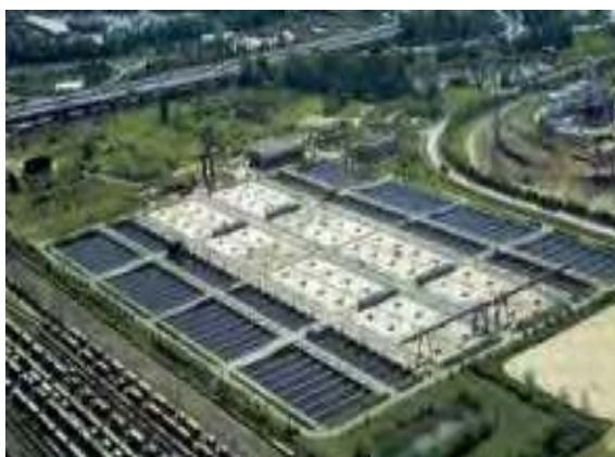
Изглед на огромна пречиствателна станция за технически води в Хамбург Източник: http://www.vdi.de/2151.0.html
