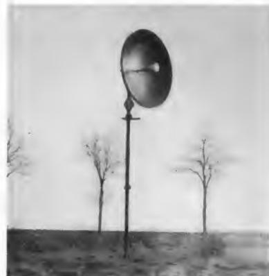
Bild 3. Scharf bündelnde Parabol-Meßantenne zum Ausmessen des Vertikaldiagramms
