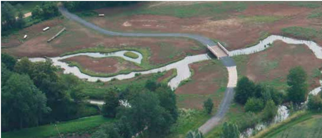
▲ Abb. 2: Luftbild des ökologischen Ausbaus der Wern - Bauabschnitt 05, Geldersheim
