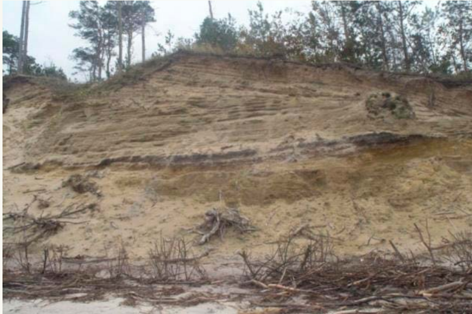
Fig. 2. Brzeg morski przed wybudowaniem opaski gabionowej w Ostrowie. Utracone bezpowrotnie walory krajobrazowe i przyrodnicze brzegu morskiego na zachód od Jastrzębiej Góry (fot. E. Zawadzka 2008)
