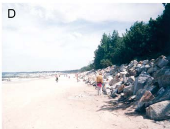
Ryc. 24. Zabiegi ochrony brzegu I, A – opaska narzutowa z gwiazdobloków, Rewal 2001, B – ścianka szczelna z oczepem stalowym, Kołobrzeg 2006, C – podcięty refulat w Mrzeżynie, 2006, D – okładzina z kamienia łamanego, Ustka 2002
