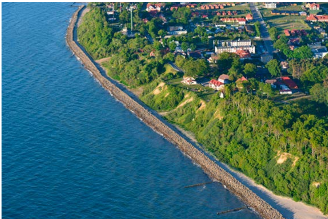
Fot. 2. Wybrzeże klifowe w Jarostaw- cu. Opaska brzegowa chroniąca ląd przed erozją
