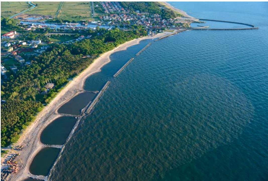
Fot. 12. Falochrony w Darłówku przy ujściu Wieprzy, po stronie wschodniej z powodu erozji wybudowano wzdłuż brzegową opaskę i falochrony. W latach 2012-2014 rozbudowywane są te umocnienia na odcinku 8 km, łącznie z mierzeją jeziora Kopań, za kwotę ponad 200 mln zł
