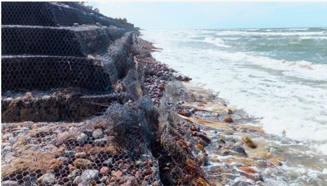
Fig. 1. Opaska gabionowa w rejonie Ostrowa do ujścia Czarnej Wody (fot. B. Płóciennik, 2012)
