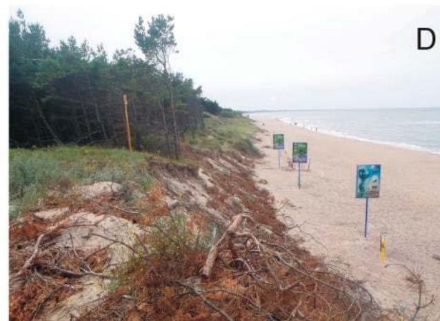
Ryc. 25. Zabiegi ochrony brzegu II, A – budowa opaski gabionowej pod klifem podczas sztormu, Jastrzębia Góra 2010, B – budowa opaski gabionowej pod niskim wybrzeżem wydmorem podczas sztormu, Ostrowo 2010, C – płotek faszynowy i chrust na wydmie przedniej, Łeba 2012, D – chrust na wysokim stoku wydmy, Łazy 2012
