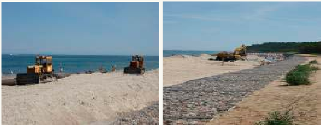
Fig. 3. Zasilanie na przedpolu opaski gabionowej w Ostrowie w celu uzyskania plaż na sezon letni, utraconych po wybudowaniu opaski, w wyniku odbić od niej, 2012 (fot. PRCiP)
