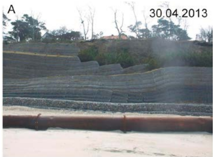
Ryc. 45. Osuwiska klifu w Jastrzębiej Górze II, A – zapadanie wysokiej opaski gabionowej wybudowanej w 2005 r., B – osuwisko ponad opaską gabionową z 2009 r.
