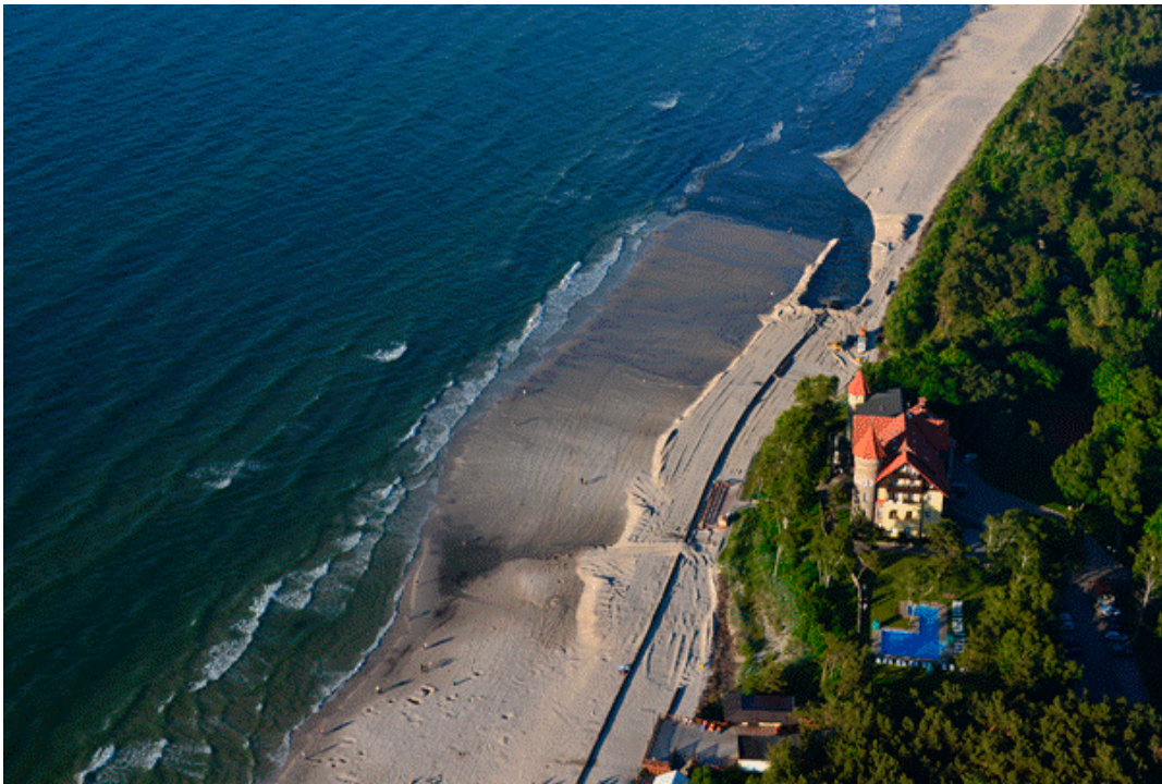
Fot. 26. Refulacja plaży w Łebie pod pałacem – hotel Neptun. Rocznie odkłada się tu od 50 do 240 tys m sześciennych piasku na odcinku 1,5 km brzegu. Metr kosztował kiedyś 20 zł, teraz już ponad 35 zł. Daje to 3-5 mln zł rocznie
