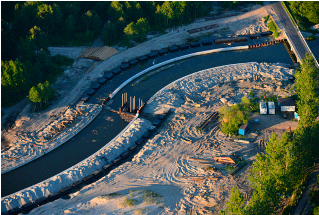
Fot. 20. Przetoka Jamneńska. Kosztem ponad 27 mln zł betonuje się brzegi, buduje śluzę, a w przyszłości falochrony wychodzące w morze. A wszystko dla „ochrony przeciwpowodziowej” dla trzcinowisk i szuwar nadbrzeżnych i ... planowanej ogromnej mariny wraz z kompleksem turystycznym
