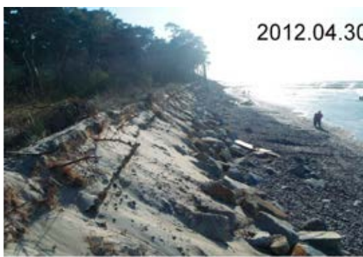
Ryc. 36. Wał przeciwsztormowy w Dźwirzynie
