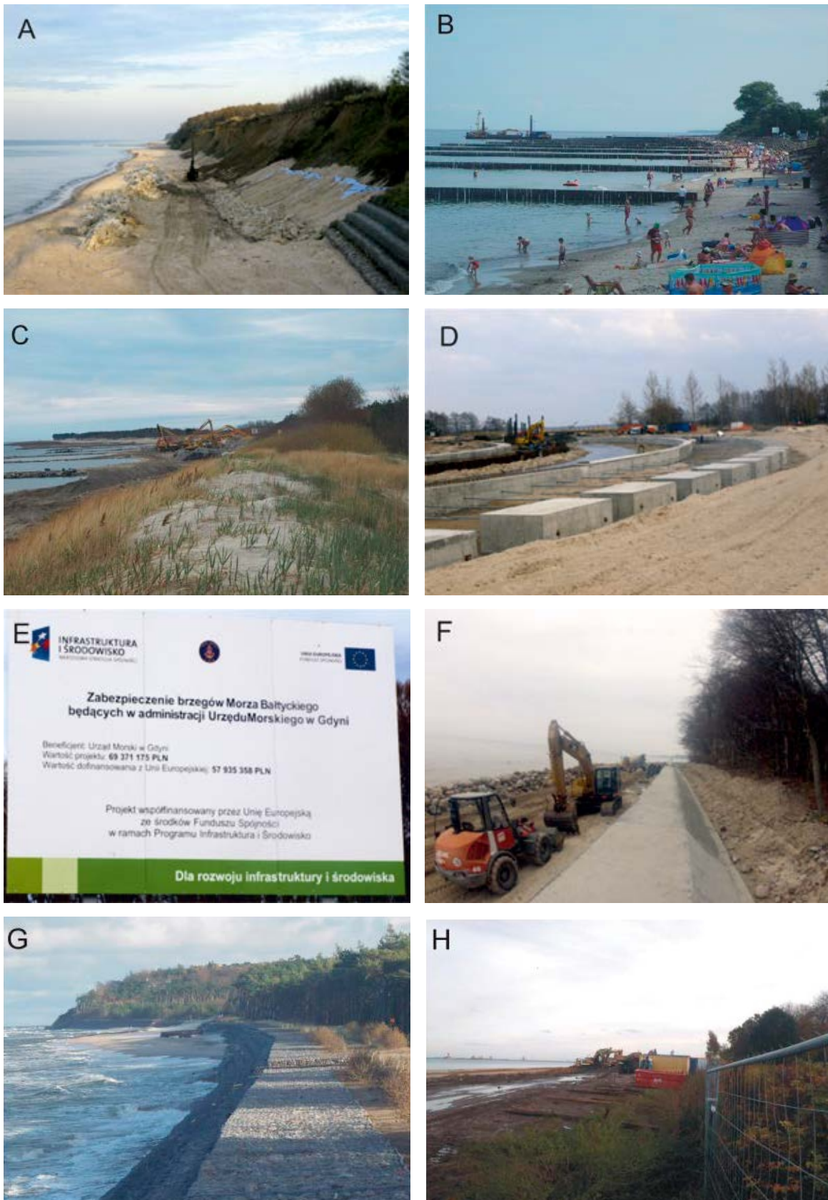
Ryc. 28. Ciężkie zabiegi, inwestycje ze środków unijnych od 2010 r. A – budowa opaski z kamienia łamanego, klif Trzęsacz, 08.2010, będzie przedłużana w 2013 r., B – budowa progów podwodnych w Kołobrzegu, widoczne nowe ostrogi, przed zasileniem plaży, 08.2012, C – budowa progów i ostróg, Darłówek – Mierzeja Kopań, 04.2013, D – regulacja kanału Jeziora Jamno wraz z budową wrót przeciwsztormowych w Unieściu, 04.2013 E – tablica informacyjna Urzędu Morskiego w Gdyni z kwotą finansowania projektu, F – przebudowa opaski w Rozewiu, G – opaska gabionowa na naturalnym, niezamieszkałym brzegu wydymowym, Ostrowo, 11.2012, H – budowa opaski na Westerplatte, 11.2012
