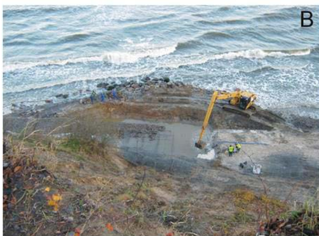
Ryc. 25. Zabiegi ochrony brzegu II, A – budowa opaski gabionowej pod klifem podczas sztormu, Jastrzębia Góra 2010, B – budowa opaski gabionowej pod niskim wybrzeżem wydmorem podczas sztormu, Ostrowo 2010, C – płotek faszynowy i chrust na wydmie przedniej, Łeba 2012, D – chrust na wysokim stoku wydmy, Łazy 2012
