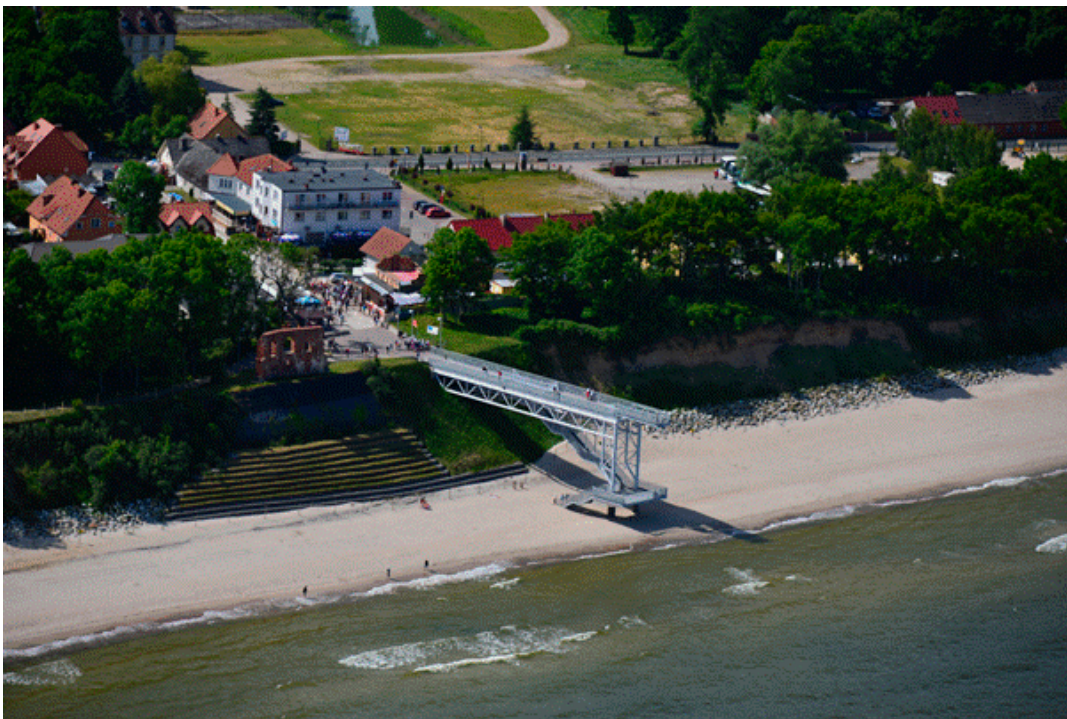
Fot. 22. Opaska gabionowa na ścianie klifu – kosztowna ochrona ruiny kościoła w Trzemeszcu. Po bokach nowa opaska kamienna, ciągnąca się na długości 3 km. W planach jest jej przedłużenie o kolejne 2 km. Spektakularny nowy pomost służy od 2009 r. turystom. Dawne schody, zniszczyło morze
