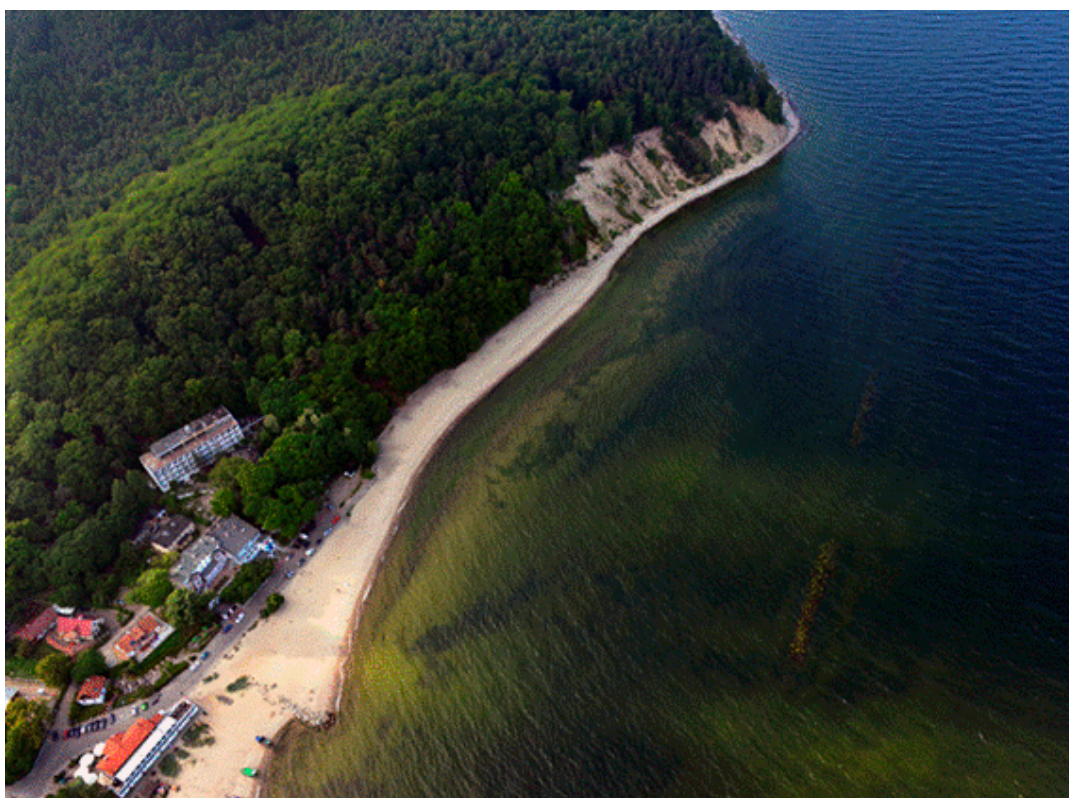
Fot. 14. Spektakularny klif w Gdyni Orłowo. Erozja na klifie jest naturalnym elementem krajobrazu. W trosce o pobliską zabudowę w 2005 r. wykonano 3 progi podwodne oraz refulowano plażę, wszystko po silnym sztormie z 2004 r. Sam klif nadal się obsypuje. Dotychczas nie było potrzeby refulacji plaż w Trójmieście, po 2007 r. i tu rozpoczęto działania – powód kurczenie plaż po silnych sztormach i brak naturalnych źródeł piasku
