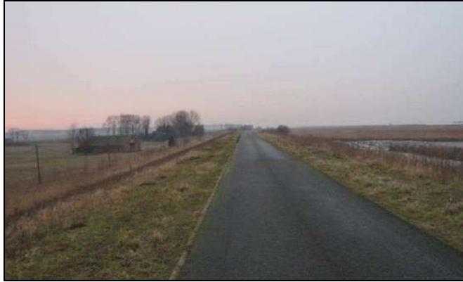
Figuur 9.9 Afbeelding van het profiel van de bestaande dienstweg bovenop de Scheldedijk. Links beneden bevindt zich de zone van de minste hinderroute waarop vrachtwagens geladen naar de werkzone kunnen rijden.
