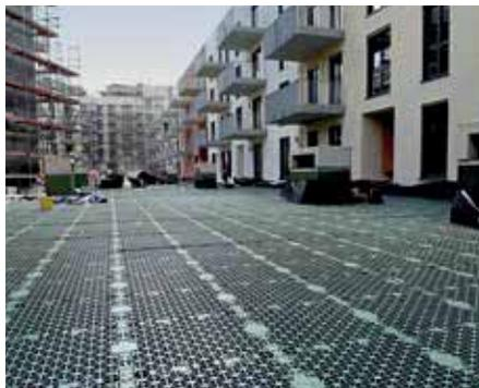
*In den Hohlräumen der vollflächig verlegten RSX 80-Elemente können mehr als 75 l/m<sup>2</sup> Regenwasser zwischengespeichert werden.*
