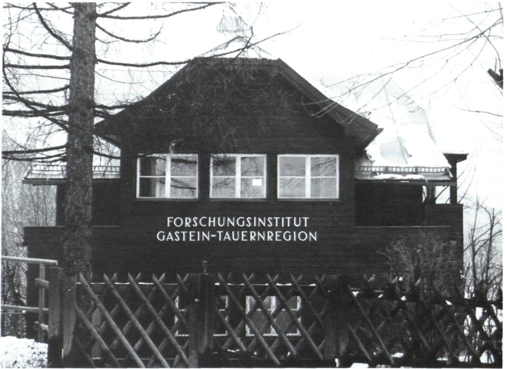
Forschungshaus in der Badbergstraße nach der Renovierung im Jahre 1982
