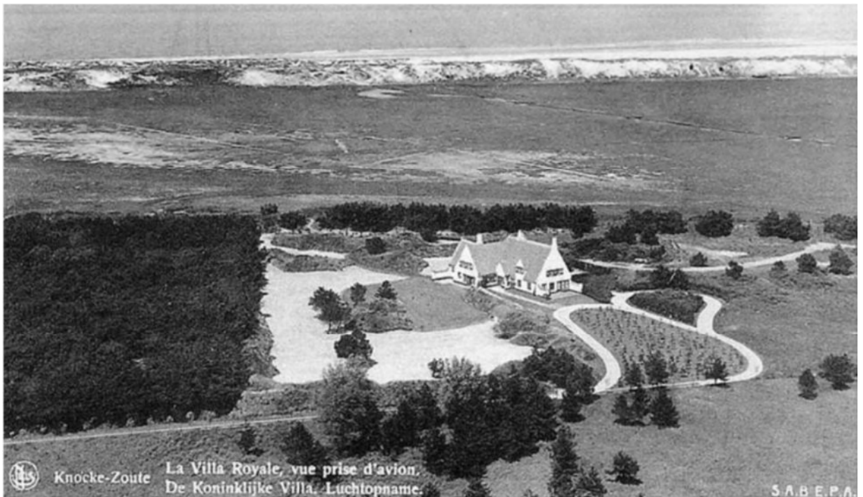
Afbeelding 1.28: luchtfoto (± 1935) van de recent gebouwde koninklijke villa (bron: www.knokke-heist.weeleer.be )
