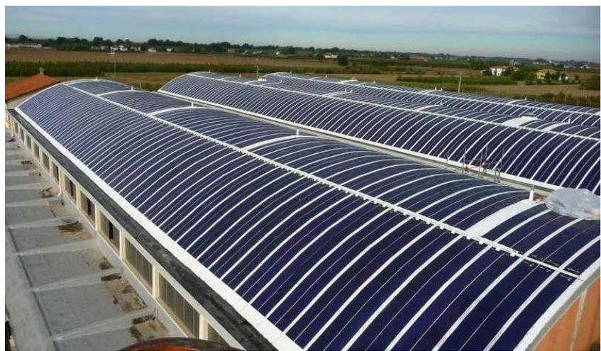
**Figura 55 - Esempio di moduli fotovoltaici flessibili Solbian (sinistra) [47]. Realizzazione con moduli flessibili Derbisolar su edifici industriali (destra) [48]**
