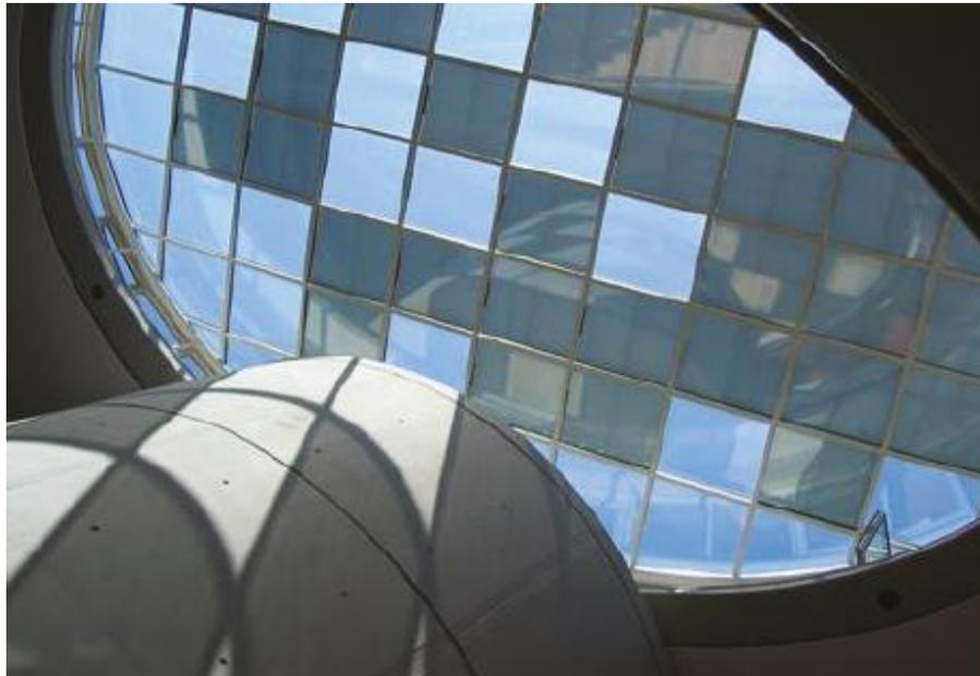
Figura 60 - Esempio di integrazione di sistemi fotovoltaici in copertura trasparente (ASI® Glass photovoltaic modules, Schott Solar AG [55]).
