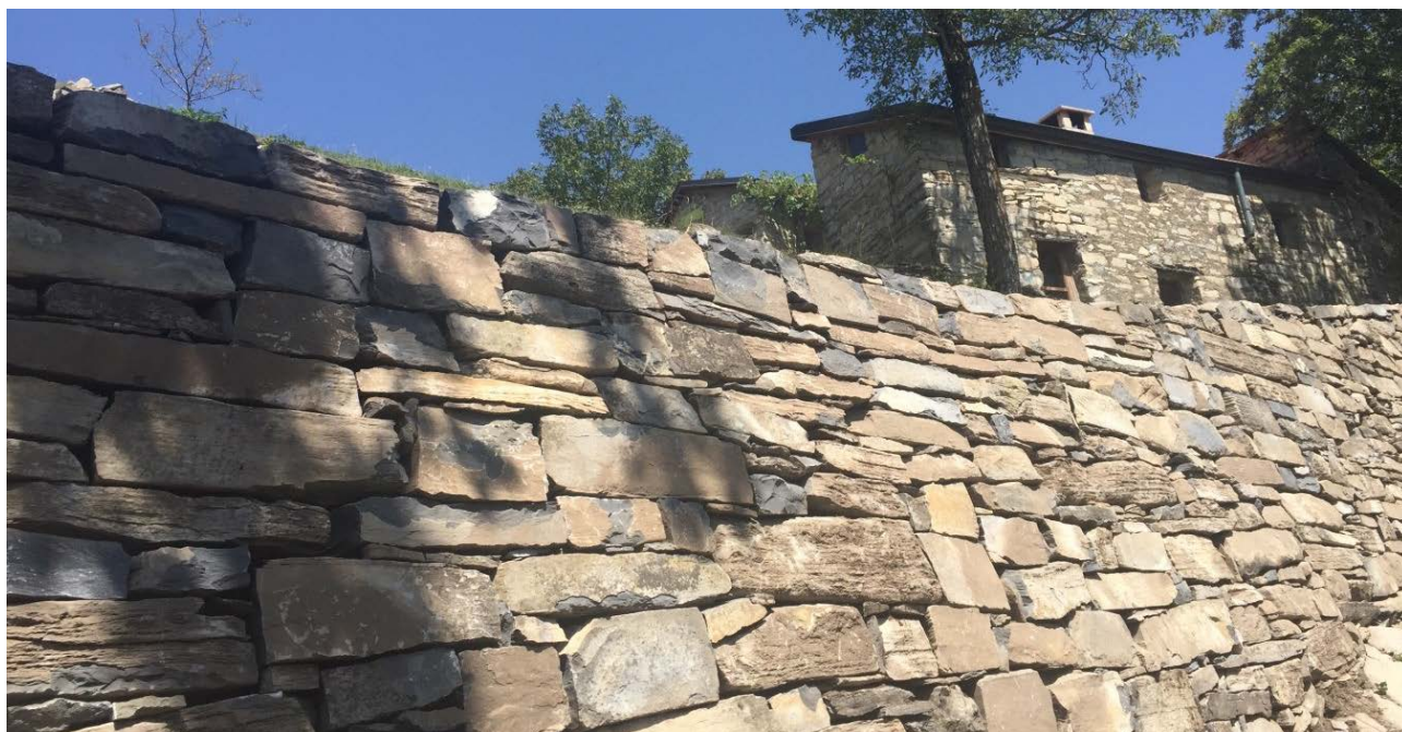
Immagine 9– Paesaggio terrazzato Valle di Muggio-Scudellate, stato 2017, dopo i lavori di rifacimento di muri in calcare.
