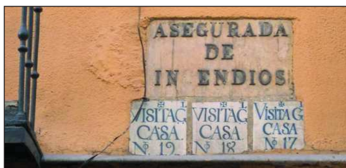
ILUSTRACIÓN 4. Madrid, calle del León. Azulejo n.º 19 identificativo de la antigua casa.
