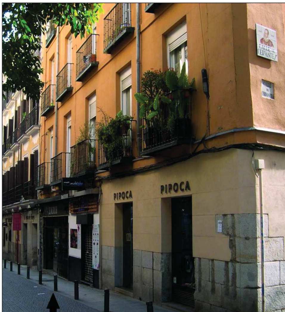
ILUSTRACIÓN 5. Madrid, calle del León. Estado actual de la casa (año 2019).
