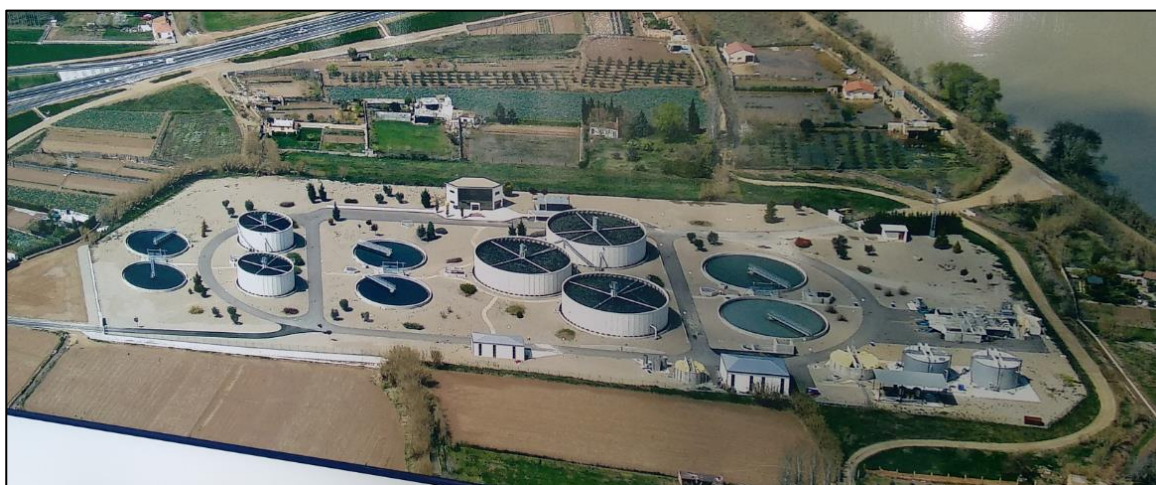
Figura 9. Vista aérea de la EDAR de Tudela (Navarra)
