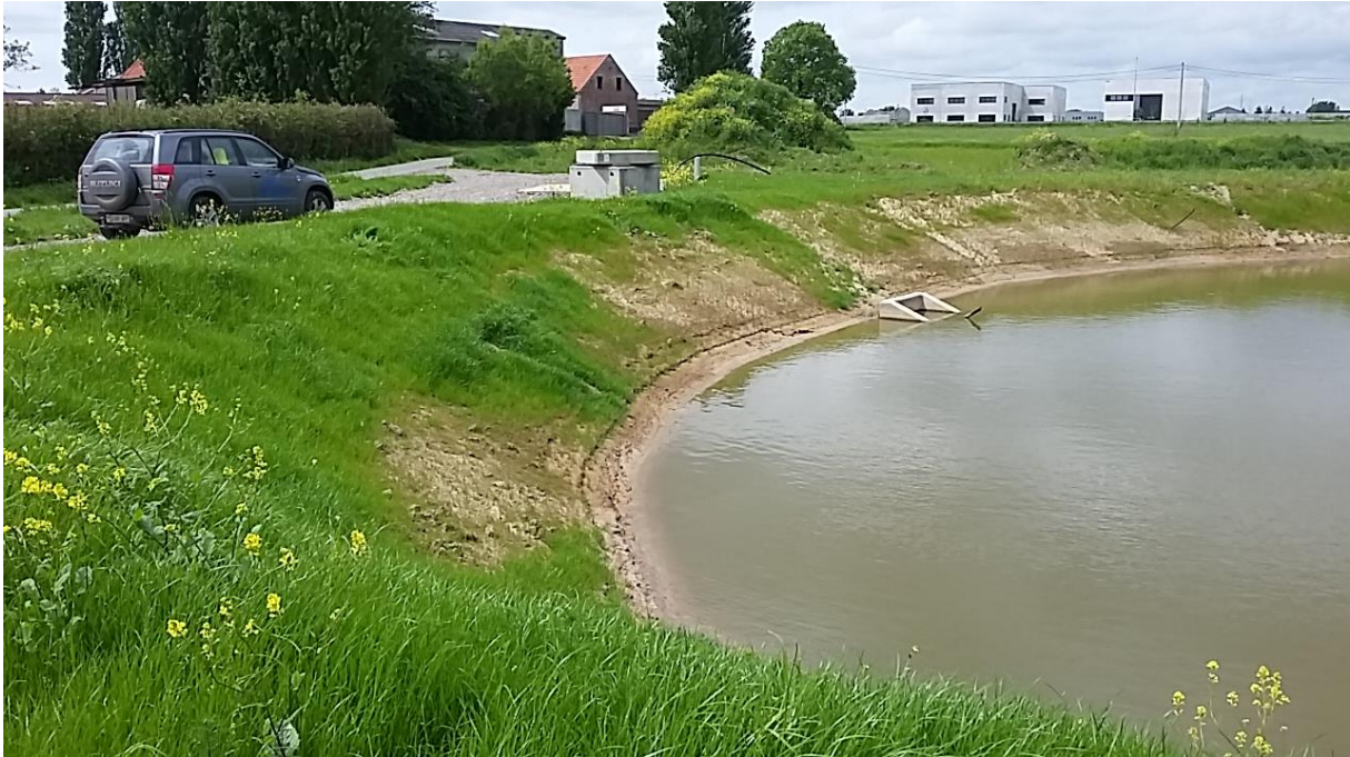
Figuur 8: voorbeeld aanleg captatiepunt Robaertbeek Poperinge
